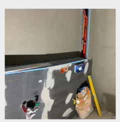
Nach der Demontage der Wände und Böden wurden Abwasser- und Frischwasserleitungen neu verlegt. Im Badezimmer kamen an Boden und Wänden (teilweise) die wedi Bauplatten zum Einsatz. Mit dem wedi Fundo Primo Duschelement wurde ein sicherer Ersatz für die Badewanne eingesetzt. Mit der wedi Bauplatte im Bodenbereich konnte ein ebenerdiger Zugang geschaffen werden. Die Tür wurde durch eine großzügige Schiebetür für einen barrierefreien Zugang ersetzt.
