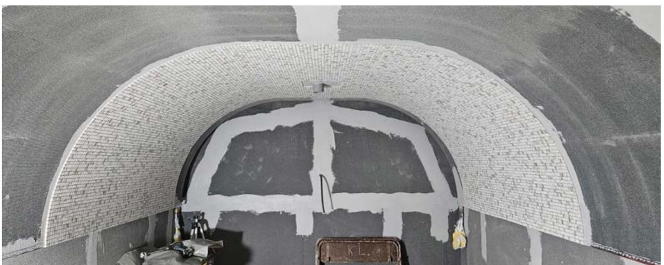
Durch das Aufbringen der werkseitigen Dampfbremse durch wedi sind bei der Abdichtung lediglich die Stöße bauseitig auszuführen.
