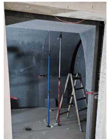
Die wedi Module sind speziell für den Einsatz in stark beanspruchten Nassräumen mit dauerhaft erhöhter Luftfeuchtigkeit mit einer Dampfbremse ausgestattet. So werden Feuchtigkeitsschäden effektiv verhindert.
