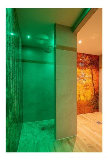
Im neuen Duschbereich wurden zwei bodengleiche Duschelemente der Fundo Primo Serie verbaut. Das werkseitig integrierte Gefälle sorgt für eine optimale Entwässerung und verhindert so zuverlässig die Bildung von Wasserpfützen.
